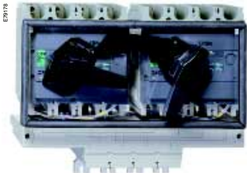
Blokada wzajemna dwóch rozłączników Interpact wyposażonych w napędy obrotowe
