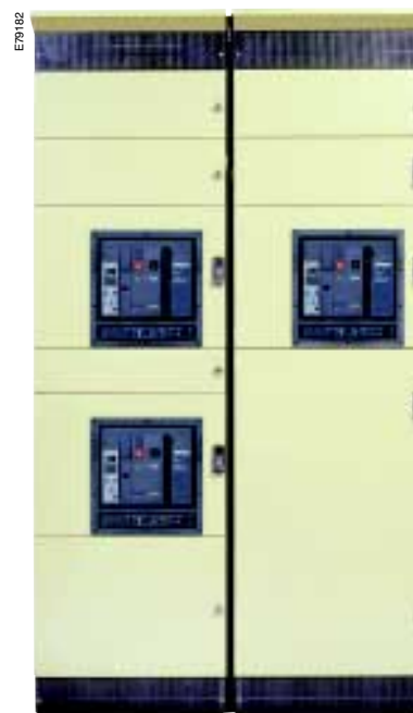
Blokada wzajemna trzech wyłączników Masterpact NW przy użyciu cięgien elastycznych
